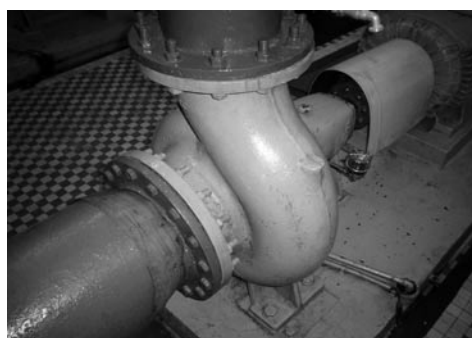
Rys. 4. Zmiana przekroju przewodu ssawnego umiejscowionym bezpośrednio przed króćcem ssawnym pompy
