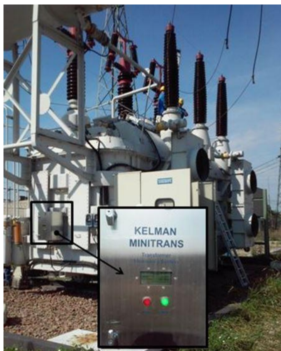
Rys. 2. Przykład instalacji systemu monitoringu zawartości wody oraz gazów w oleju na autotransformatorze 160 MVA
